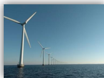
Visite St Nazaire - Avril Parc éolien
